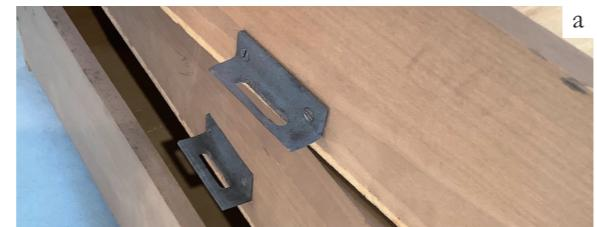
釘打ち箇所の上に蟻組みをかたどった薄板(厚さ7~8mm)を貼っている。強度の面からは、意味はない。後ろ側の仕口は釘打ちされたままになっている。引き出しを引いた際に、見える部分だけ蟻組みしたかのように見せているのだ。おそらく、職人としては、本当は蟻組みでしっかり作りたかったのだろう。しかし、何らかの事情で釘留めすることになったことに対して、せめてもの意地を見せたのかもしれない。
